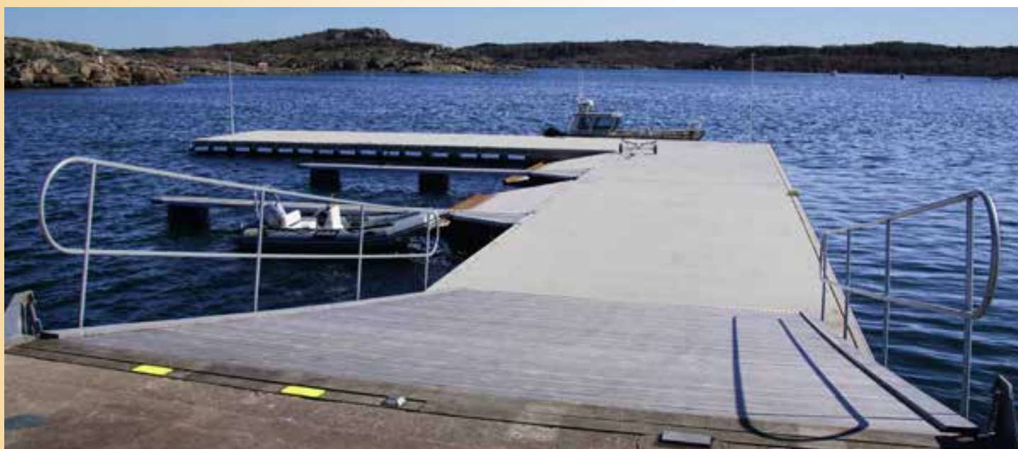
Ny brygga med ramp ner från kajen. Bred och stabil. Gör det möjligt att sjösätta flera båtar samtidigt.
