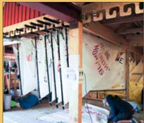
Hängandes från taket. Krokar, hyllor och fack i taket kan användas flexibelt och tillfälligt för stora otympliga saker som behöver hänga och torka.
