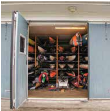
Förråd för kanoter i tempererat utrymme med breda dörrar längs hela förrådet möjliggör snabb och lätt hantering. Förrådet är lagom djupt för en kanot på längden.
