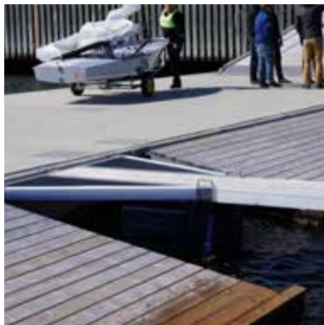
Ramper för sjösättning och upptagning. Tillräckligt breda för två båtar samtidigt. Yta av trä. Båtbommar går ut långt mellan ramperna för att underlätta och assistera vid sjösättning/upptagning.
