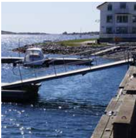
Ramp ner från den höga kajen. Flexibel för tidvattnet, men ändå relativt brant. Även denna tillräckligt bred för två båtar att mötas, vilket är en nyckelfaktor. Säkerhetsräcke på sidorna. Material av trä för ytan, och stål som bärande.
