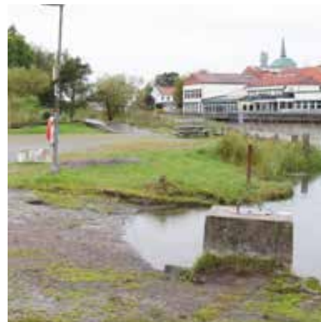
Stranden (med ramp) framför klubbhuset. Tomten ligger mycket nära vattennivån, vilket underlättar vid iläggning och upptagning, men orsakar ibland översvämningar i klubbhuset.
