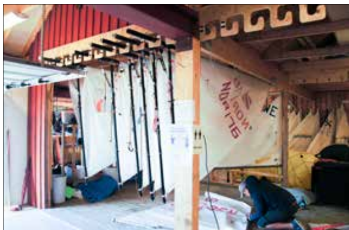
(B) Pelare och bjälklag av trä, med infällda krokar i taket. Det syns även betonggolv, samt stor garagedörröppning utåt som gör det lätt att rulla in vagnar.
