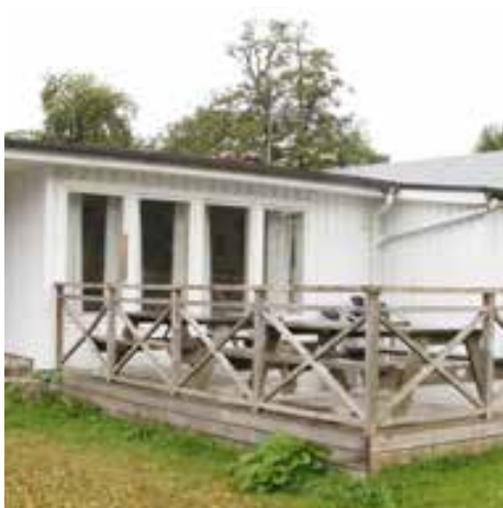
Altan (J) på norra sidan av klubbhuset (ut mot vattnet), och stora fönster från samlingsrummet skapar bra platser för gemenskap under och efter träning.
